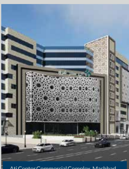
Ati Center Commercial Complex, Mashhad Ati Center Ticaret Kompleksi, Meşhed المجمع التجاري اتي سنتر مشهد
