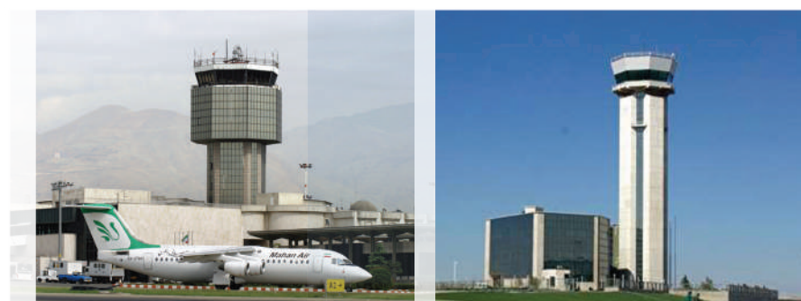
برج مراقبت فرودگاه مهرآباد
